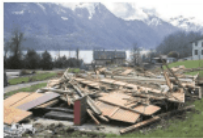
Seit Oktober werden auf dem Areal die alten Gebäude abgerissen. Das Bauprojekt umfasst weit über die Baufirma Steiner AG aus Bern. Im März sollen die Gebäude entstehen. (s. 2)
